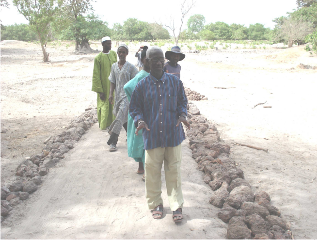
Diguette en cours de réalisation par les villageois pour compléter l'action de la digue de Marakissa.
