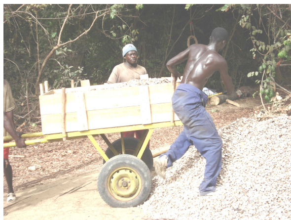
Déchargement des coquillages sur le chantier de la citerne de Mantate.
