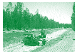
Travaux d'aménagement des alvéoles pour l'enfouissement technique des refus de déchets.
