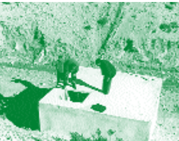
aménagement d'un point d'eau, une rurale de Jbarna
