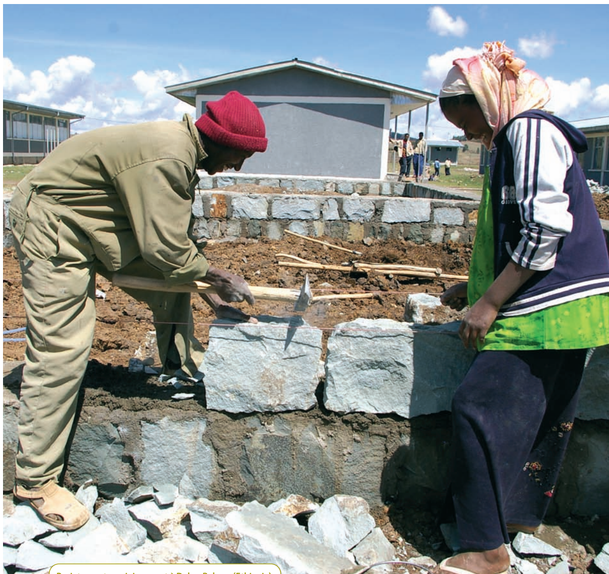
Projet eau et assainissement à Debre Behran (Ethiopie) – ville de Blanc-Mesnil. Travaux de construction.
