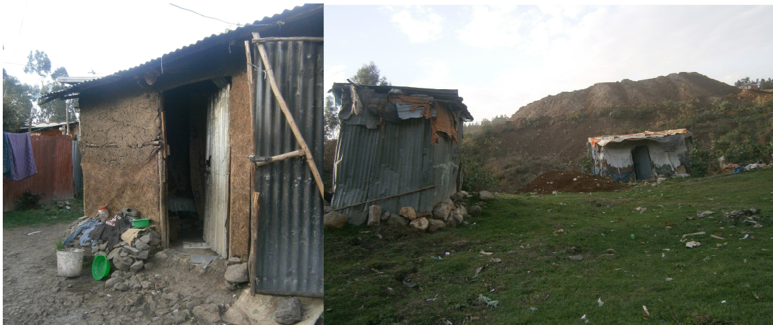
Photo 2 : Logements d'IWPAR à Addis Ababa
