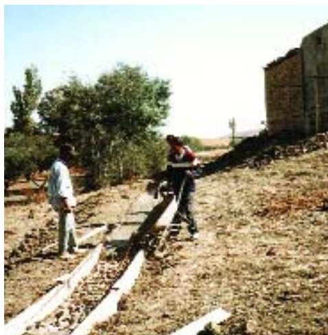
Aménagement d'une segouia
