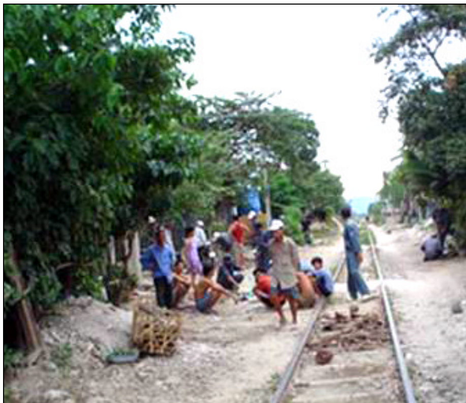
Participation communautaire à la pose de pipelines d'adduction d'eau au Vietnam
