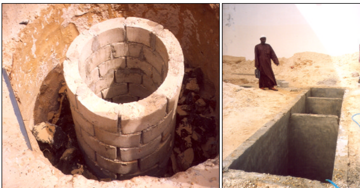
Systèmes d'assainissement à faible coût (puisard et fosse) en construction à Sicap Mbao (Sénégal)
