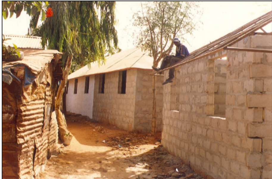
Restructuration de l'habitat dans le bidonville de Baraka (Dakar)
