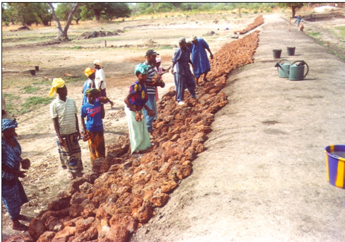
Enda mobilise et encadre les populations dans la construction de digues-barrages à Kolda (Casamance)
