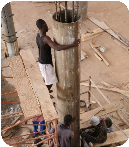
Travaux de rénovation du marché central de Ouagadougou au Burkina Faso. © Paul Kabré
